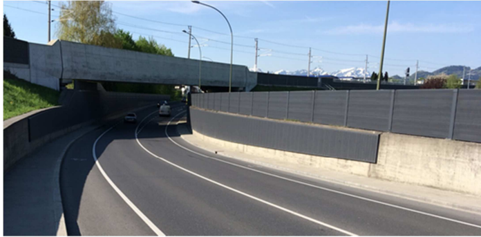
Abb. 4: Bahnunterführung L203 Lustenau (Quelle: Land Vorarlberg)
