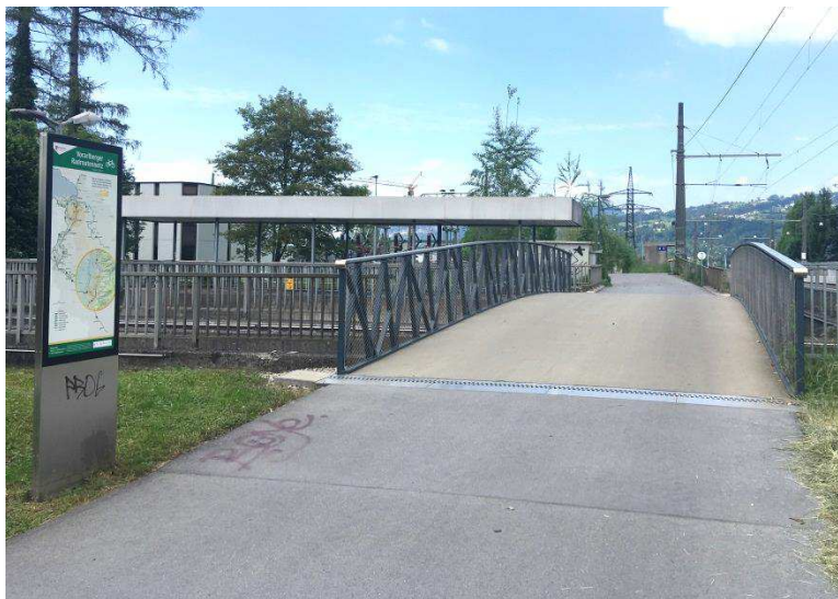
Abb. 14: Neue Radbrücke Stiglingen/Dornbirn (Quelle: Land Vorarlberg)
