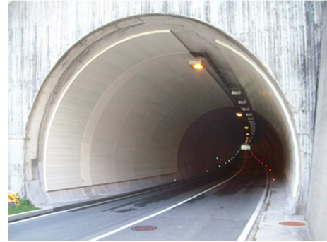
Abb. 5: Tunnelauskleidung Sulztobel; (Quelle: Land Vorarlberg)
